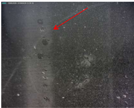
5 meses após do tratamento da turbina eólica com REWITEC®
